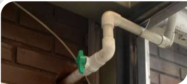
FOTO No. 8 Registro de Tanque de almacenamiento
